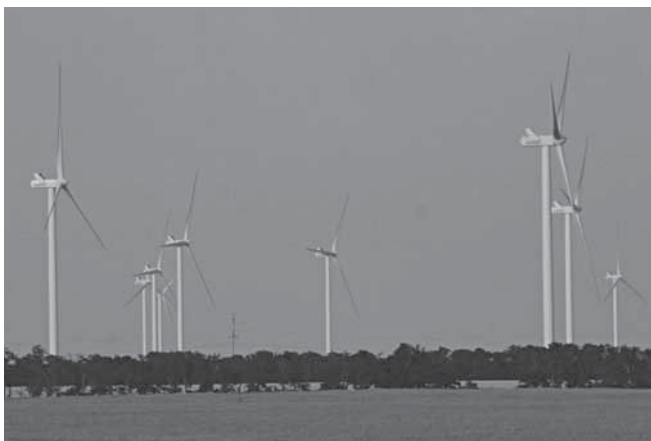
Ботиевская ВЭС. Источник фото: НТЦ «Психея»
